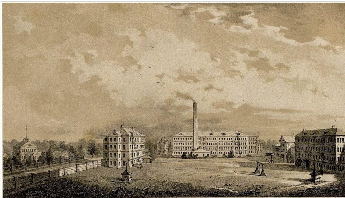
Рис. 6. Бумагопрядильная фабрика Мазуриных в сельце Реутове близ Москвы. В 1853 г. здесь трудились 874 рабочих и годовое производство составило 671 тыс. руб. серебром. Действовали паровые машины мощностью 60 л.с. Литография из книги С.А. Тарасова «Статистическое обозрение промышленности Московской губернии» (1856)
