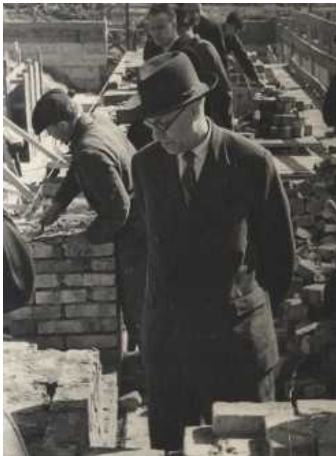
Рис. 3. М.А. Лаврентьев на строительстве Института гидродинамики – первенца Новосибирского Академгородка. 1958 г. Снимок предоставлен Фотоархивом СО РАН
