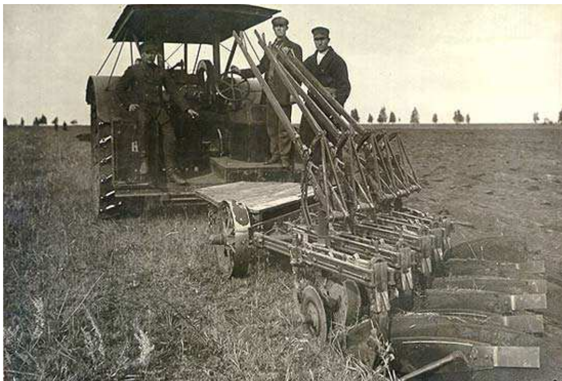
Трактор Международной компании жатвенных машин (США) в работе с многокорпусным плугом. Омск, начало XX в.
