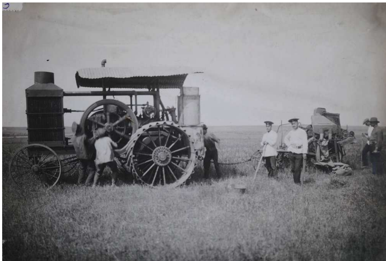
Первый американский колёсный трактор Харт-Парр-3060 («Hart-Parr») проходит испытания на полях Омской машиноиспытательной станции. 1914 г.
